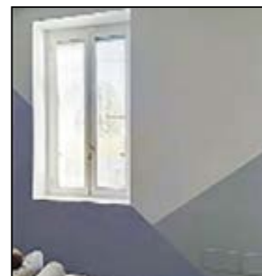
Pittura di interni
